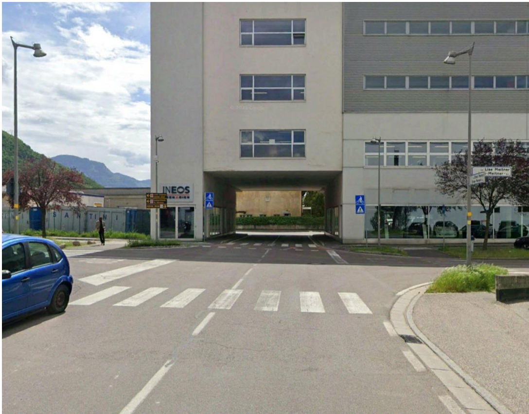
Nördliche Zufahrt zur Zone über die Lise Meitner Straße Accesso sul lato nord attraverso via Lise Meitner
