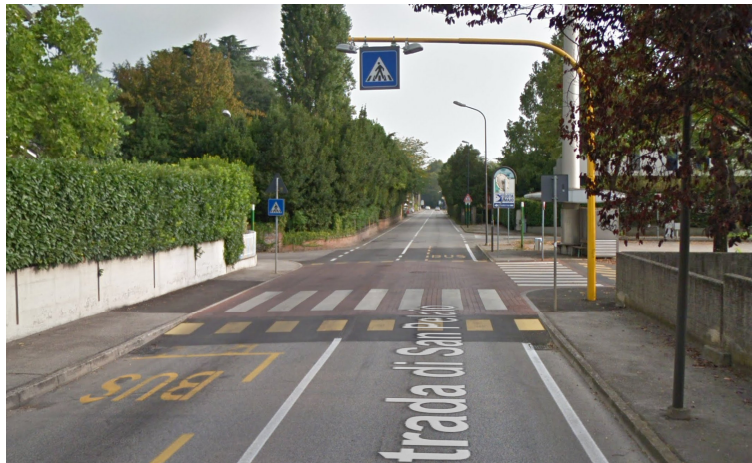
Abb. 26.4 Beispiel für eine angehobene Kreuzung
