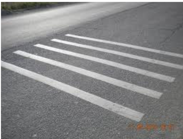
Figg. 26.2 Beispiele für Querbänder und Rüttelstreifen
