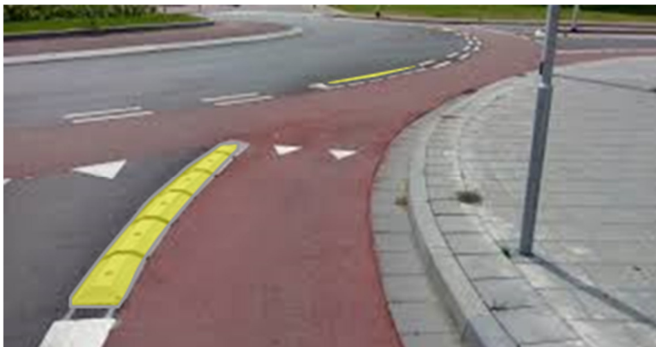
Abb. 20.2 - Radwegtrennbügel als Schutzmaßnahme für Radwege
