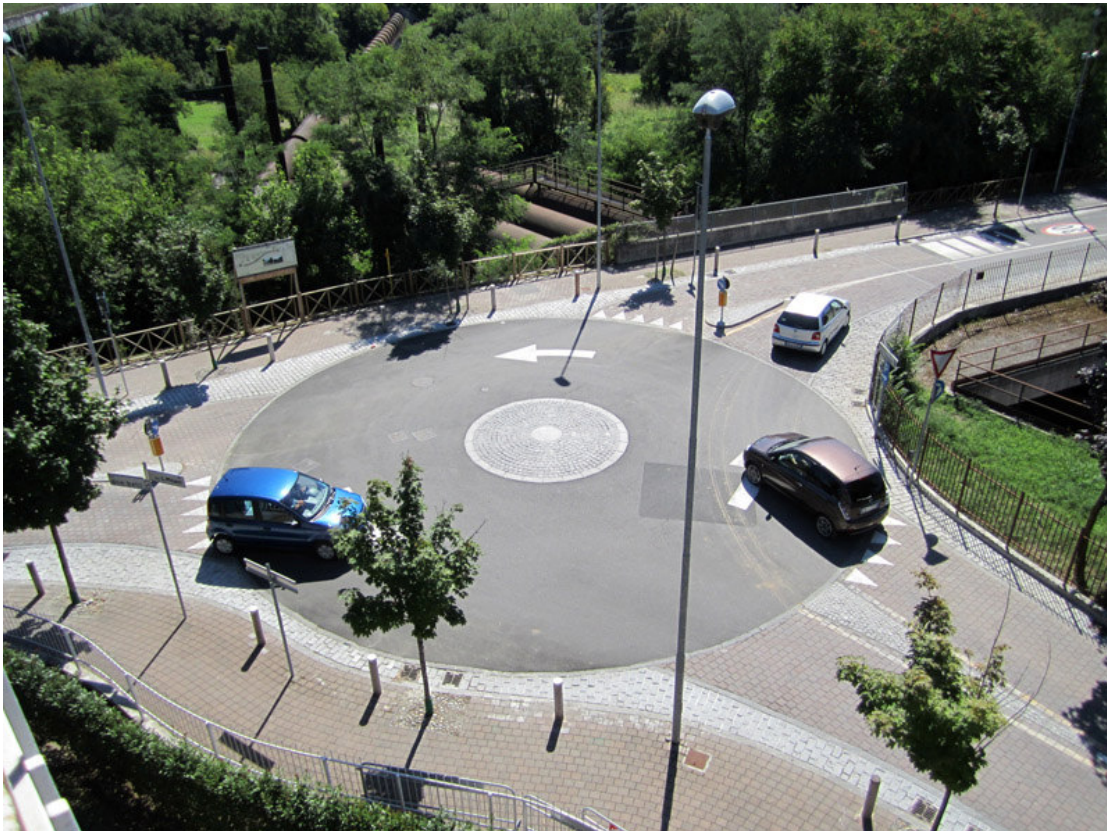
Abb. 26.16 Beispiel eines vollständig überfahrbaren Kreisverkehrs. In diesem Fall unterbricht der Kreisverkehr eine Gerade und stellt eine Maßnahme zur Verkehrsberuhigung dar
