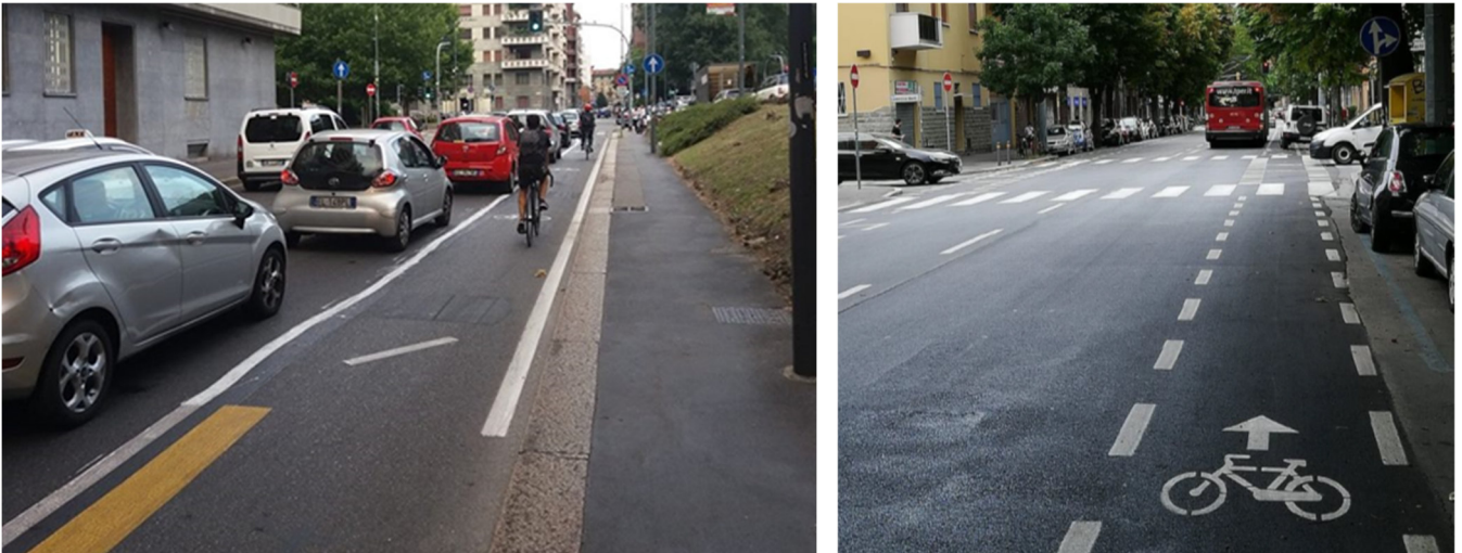
Figg. 29.11 Beispiel eines Radfahrstreifens mit durchgehender Linie und einer Radfahrbahn mit unterbrochener Linie an einem Haltestellenrandstreifen
