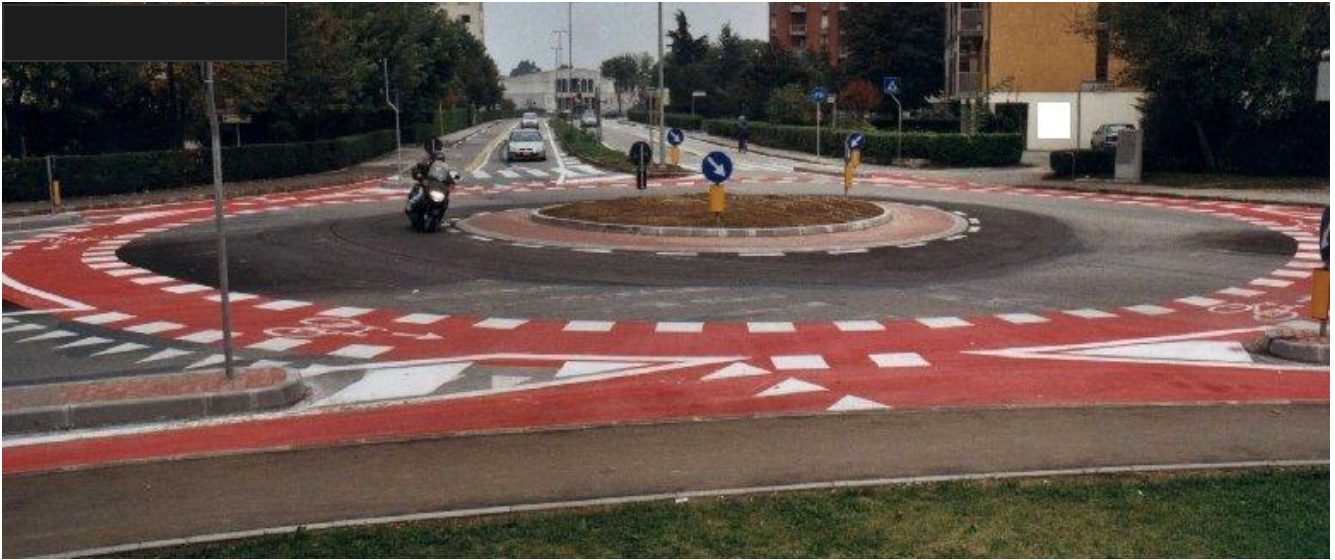
Abb. 20.3 - Beispiel ein für farbiges Radwegband am Ring und an den Ein- und Ausfahrten
