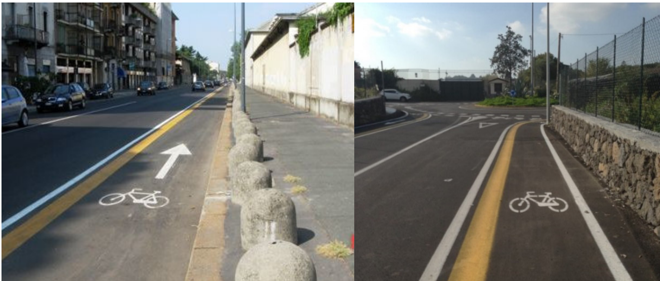
Figg. 29.7 Beispiele für einen Radfahrstreifen mit reservierter Fahrspur in Richtung des angrenzenden Fahrstreifens
