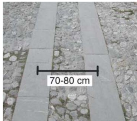
Abb. 27.2 Beispiel eines Kopfsteinpflasters mit Laufstreifen
