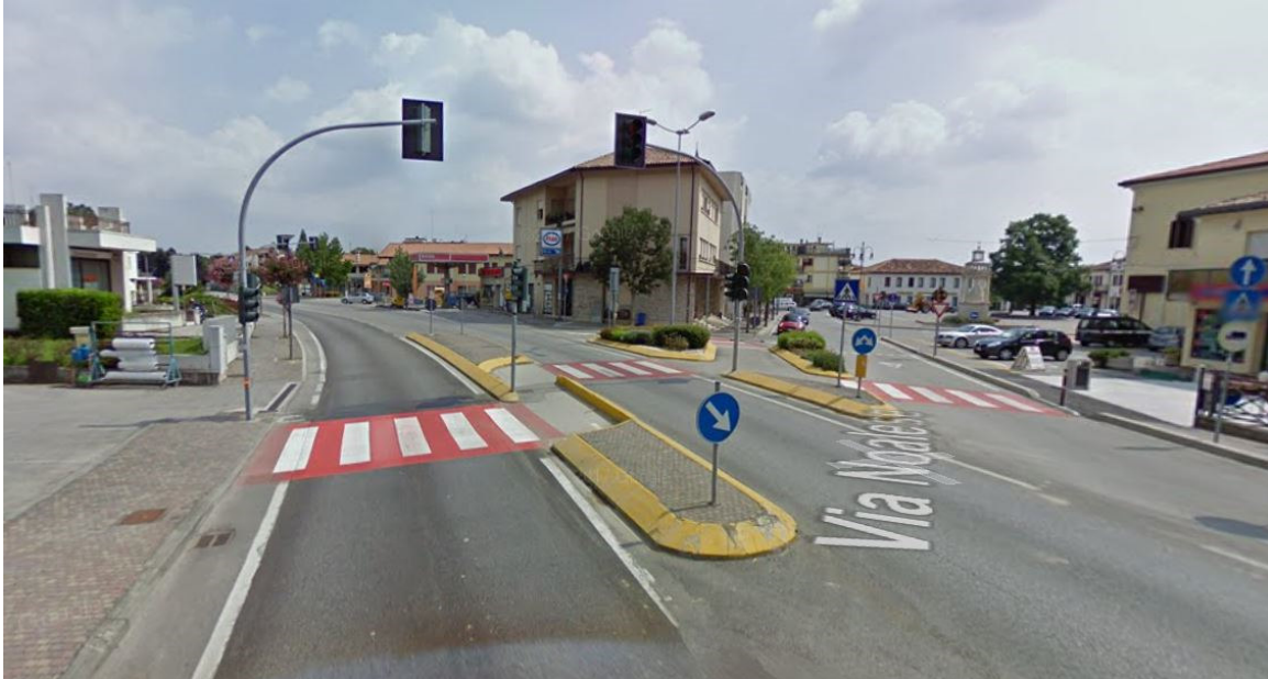
Abb. 28.1 Beispiel eines Fußgängerüberwegs mit hakenförmiger Schutzinsel
