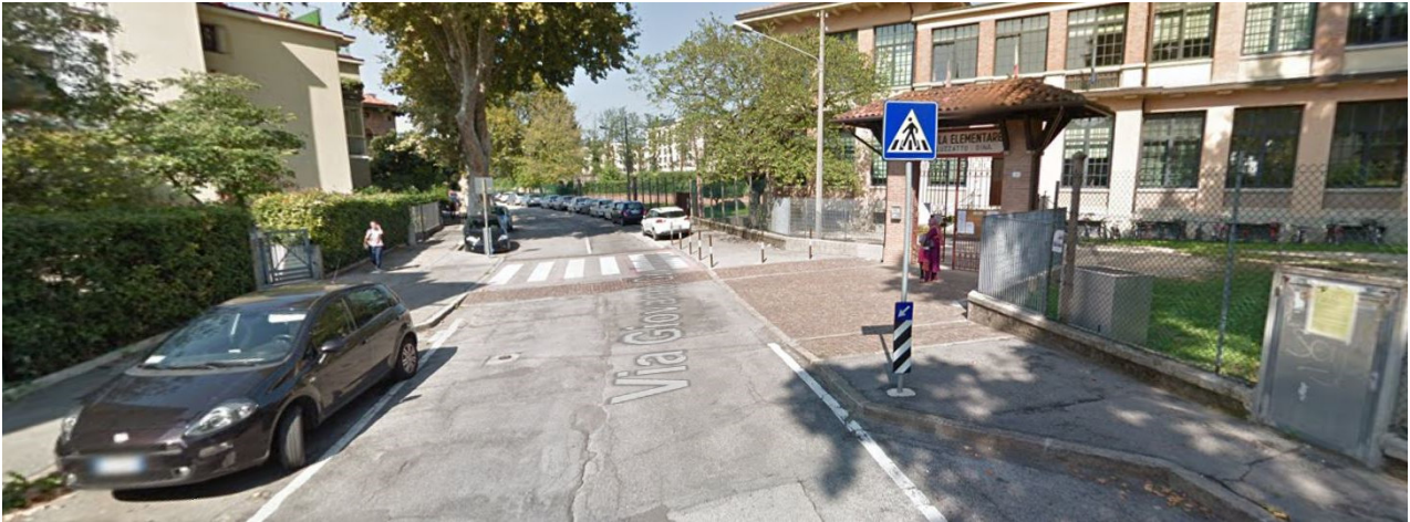
Abb. 26.13 Beispiel einer Fahrbahnverengung durch Reduzierung von Parkflächen und Vorziehen des Gehwegs in Verbindung mit einem Fußgängerüberweg und einer erhöhten Plattform (Padua)
