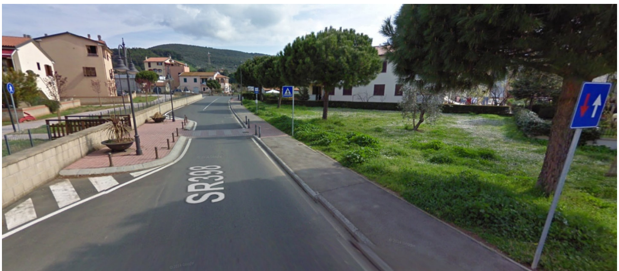
Abb. 26.14 Beispiel eines geschützten Fußgängerüberwegs mit Fahrbahnverengung und Einführung eines wechselseitigen Einrichtungsverkehrs (Venturina - LI)
