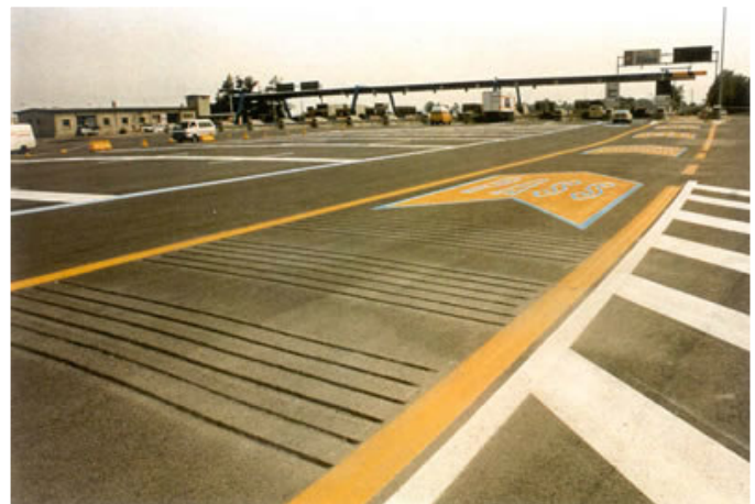
Figg. 26.2 Beispiele für Querbänder und Rüttelstreifen
