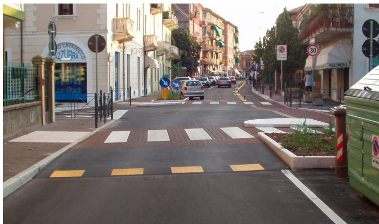
Abb. 26.7 Schikane mit alternierenden Parkflächen und gleichzeitig erhöhtem Asphaltpodest (Verona)
