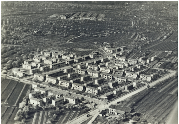
Der erste Baulos der Semirurali-Häuser wurde zwischen den 27. Juni 1938 und dem 22. April 1939 errichtet.
