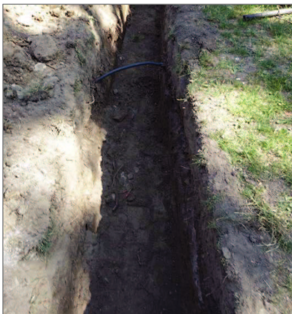
Abbildung 3: Realisierung der Schachtung und des Wurzelvorhanges
