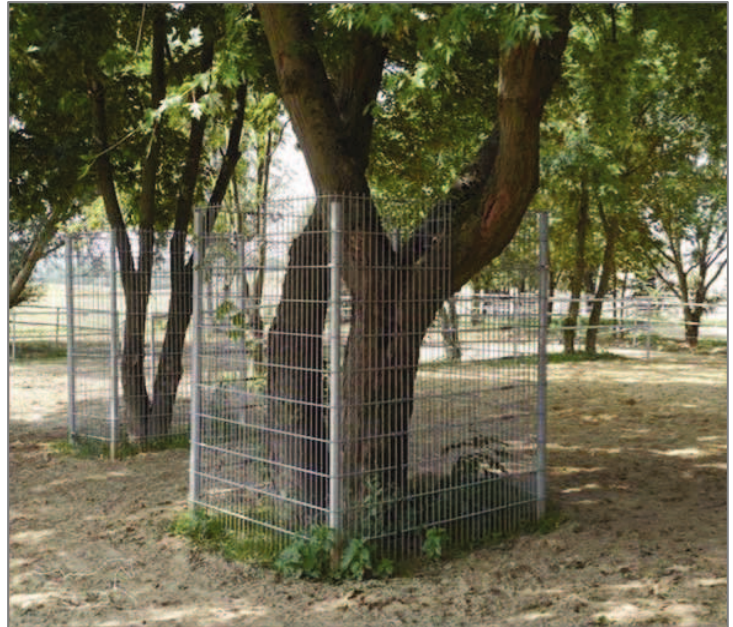
Abbildung 4: Stammschutz zum Vermeiden von Schäden im Zuge der Bauarbeiten
