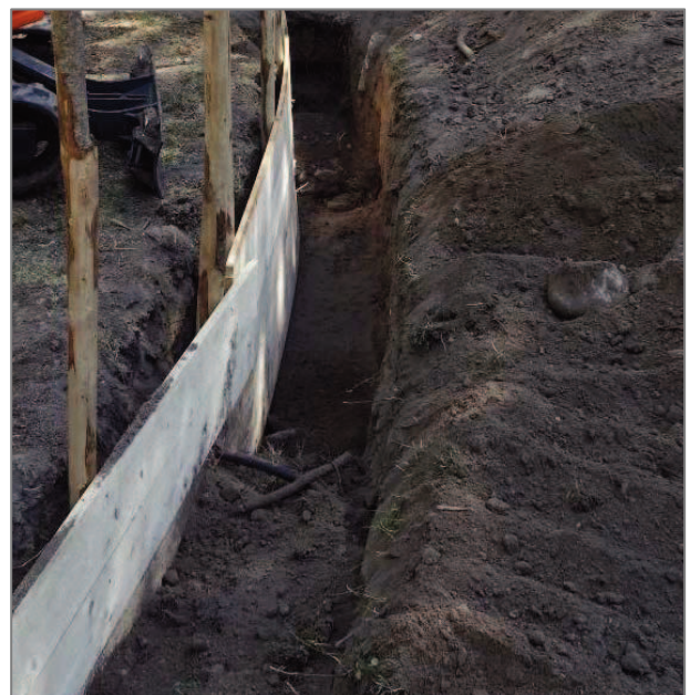
Abbildung 3: Realisierung der Schachtung und des Wurzelvorhanges
