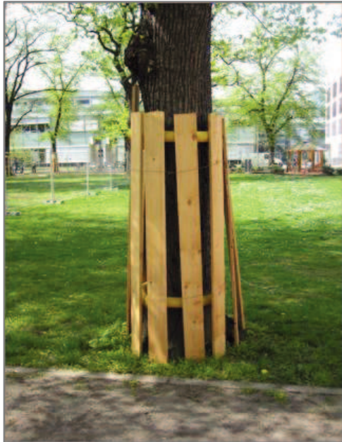
Abbildung 4: Stammschutz zum Vermeiden von Schäden im Zuge der Bauarbeiten
