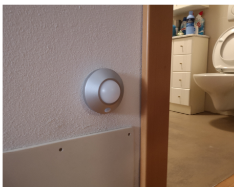
Bild 4.1.9 Bewegungsmelder für das automatische Einschalten der Nachtbeleuchtung im Gang
