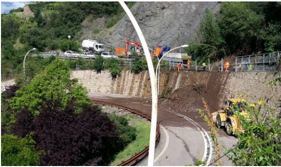
Abb. 10 Murenabgänge nach Starkregen
